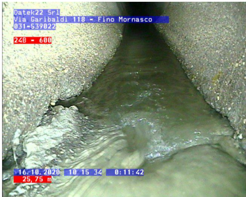
TUBAZIONE LINEA 24B - 600 Scavernamento
