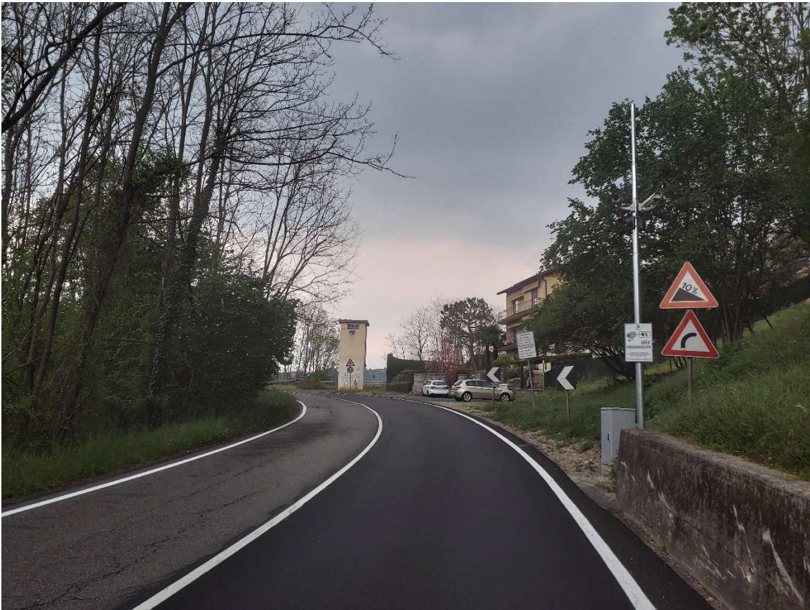
Sito 4 - Via Fontanelle , che collega la frazione Gurone (Malnate) con Vedano Olona;
