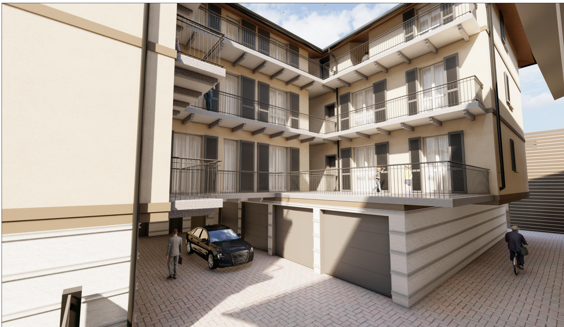
VISTA INTERNA EDIFICIO "A"
