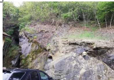
M5 - Via Fiume - Crotto
