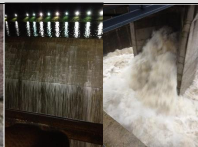
Diga Gurone - sfioratori inazione - 26/12/2013
