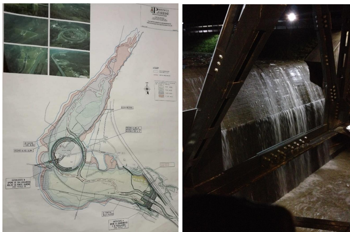
Immagini – Sx: estratto fasce progetto diga del Gurone – Provincia di Varese– Dx: Diga del Gurone, sfioratori in azione durante la piena del 26/12/2013 (Foto GCPC di Malnate)
