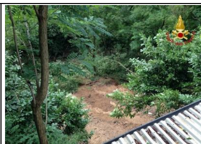
M8 – Quadronna – San Salvatore – versanti instabili
