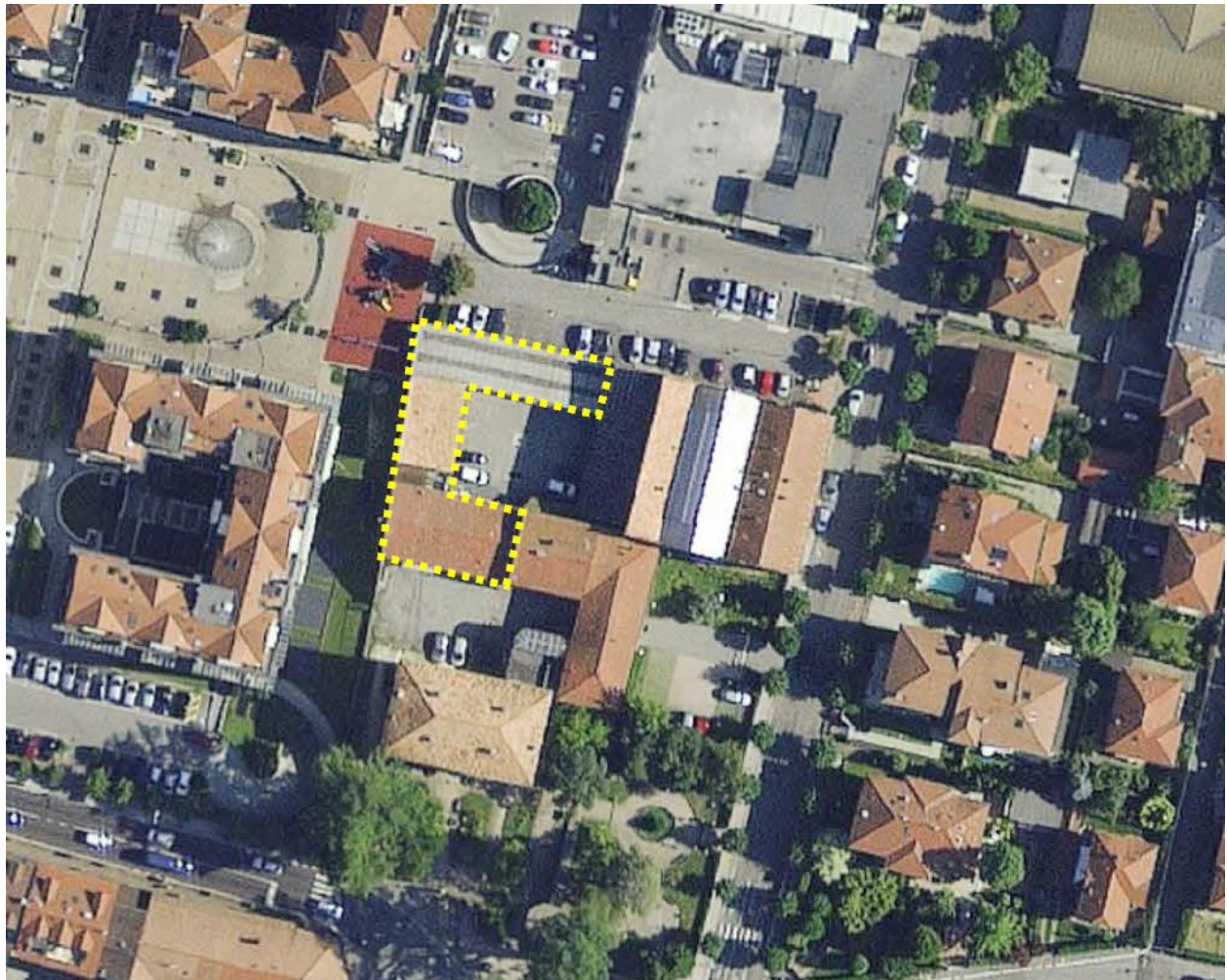
Ortofoto dell'intervento con evidenziati i fabbricati già demoliti.
