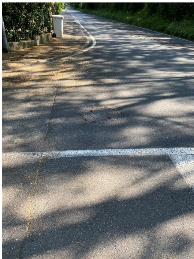
Foto 17: Via Doberdo' / via Gioberti
