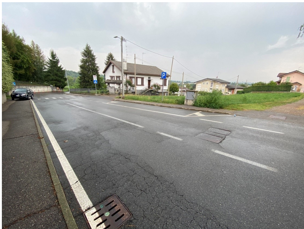
Foto 15: Via Settembrini luogo installazione attraversamento rialzato
