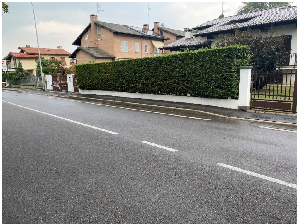
Foto 9: Via Settembrini: luogo installazione attraversamento rialzato
