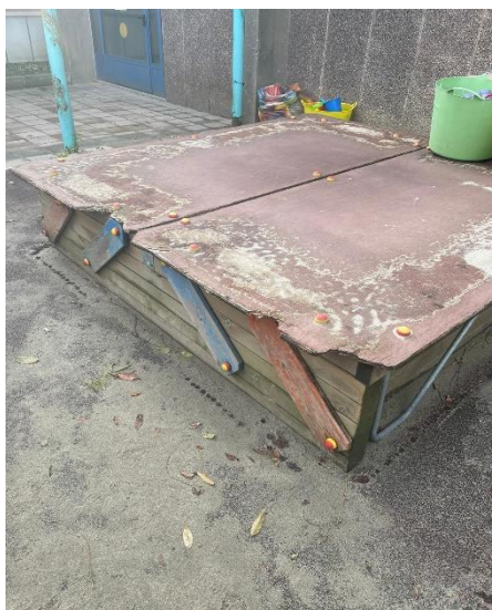
Fig. 4: copertura della sabbionaia usurata.
