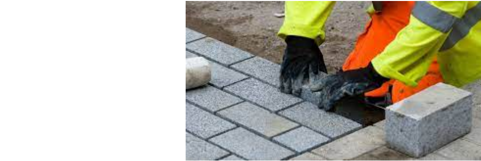
pavimentazione cementizia in masselli autobloccanti
