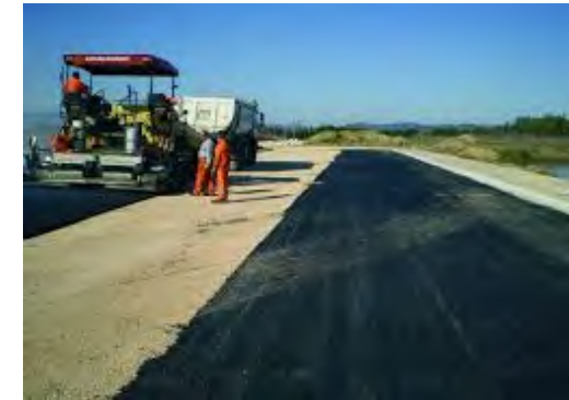
pavimentazioni in conglomerato bituminoso con varie stratigrafie
