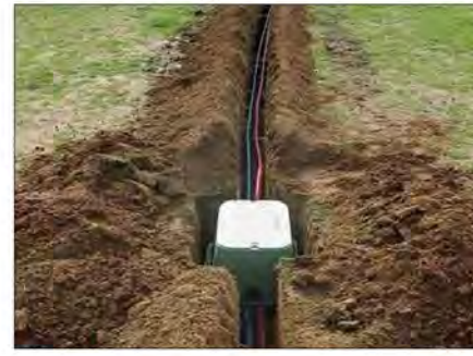
centralina interrata e derivazione di presa
