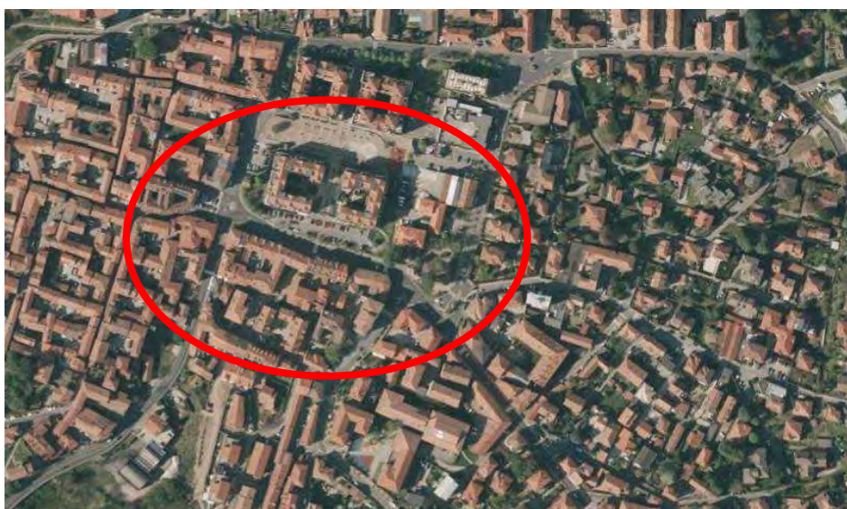
Figura 3 – Foto aeree dell'area di intervento (Fonte: Geoportale Regione Lombardia)
