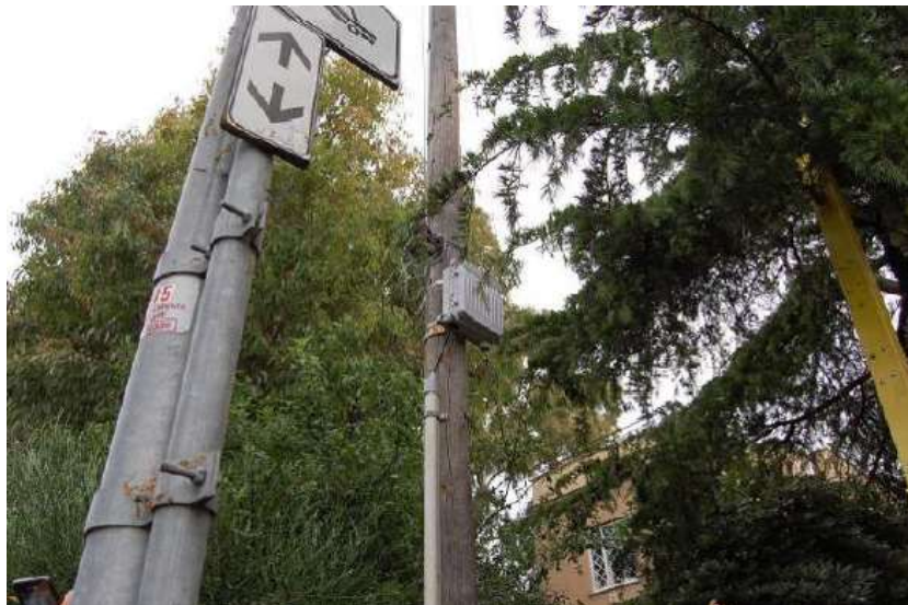
Esempi di installazione DEL PTA su palo
