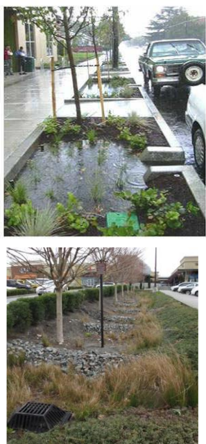
Figura 48 – Interventi d'invarianza idraulica per la viabilità: aiuole e cunette
