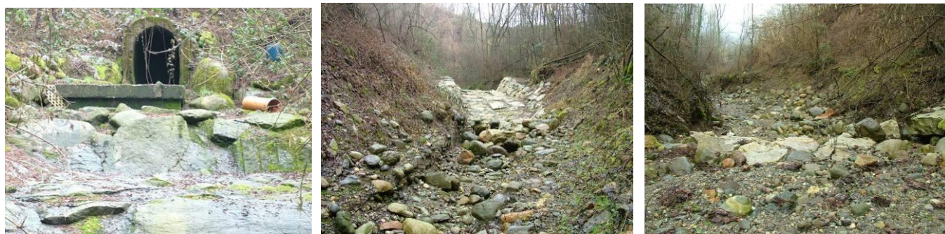
Figura 13 - Manufatti di sbocco del tratto tombinato in corrispondenza dei due rami, principale e secondario e tipologia di alveo a valle
