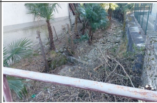
Foto – Rio chignolo – Nose' – ponte di attraversamento
