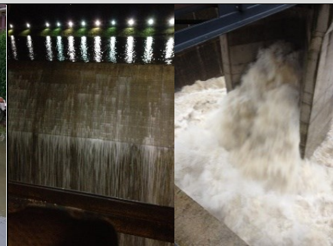
Diga Gurone – sfioratori in azione – 26/12/2013
