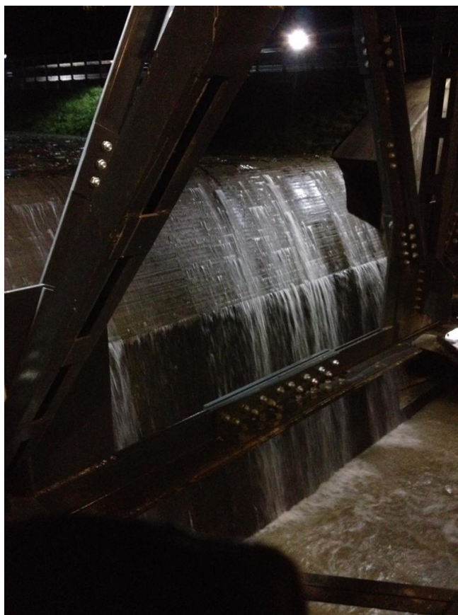
Immagini – Sx: estratto fasce progetto diga del Gurone – Provincia di Varese – Dx: Diga del Gurone, sfioratori in azione durante la piena del 26/12/2013 (Foto GCPC di Malnate)
