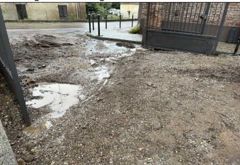
M5 – Via Fiume – Crotto – Allagamento 09/2023
