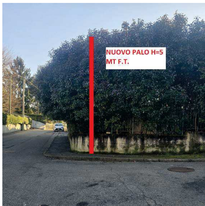
Foto 5 – Nuovo palo di installazione delle telecamere
