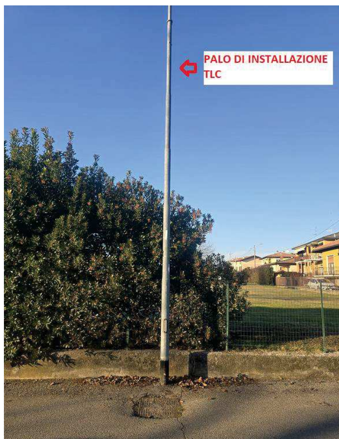
Foto 11 – Palo di installazione delle telecamere
