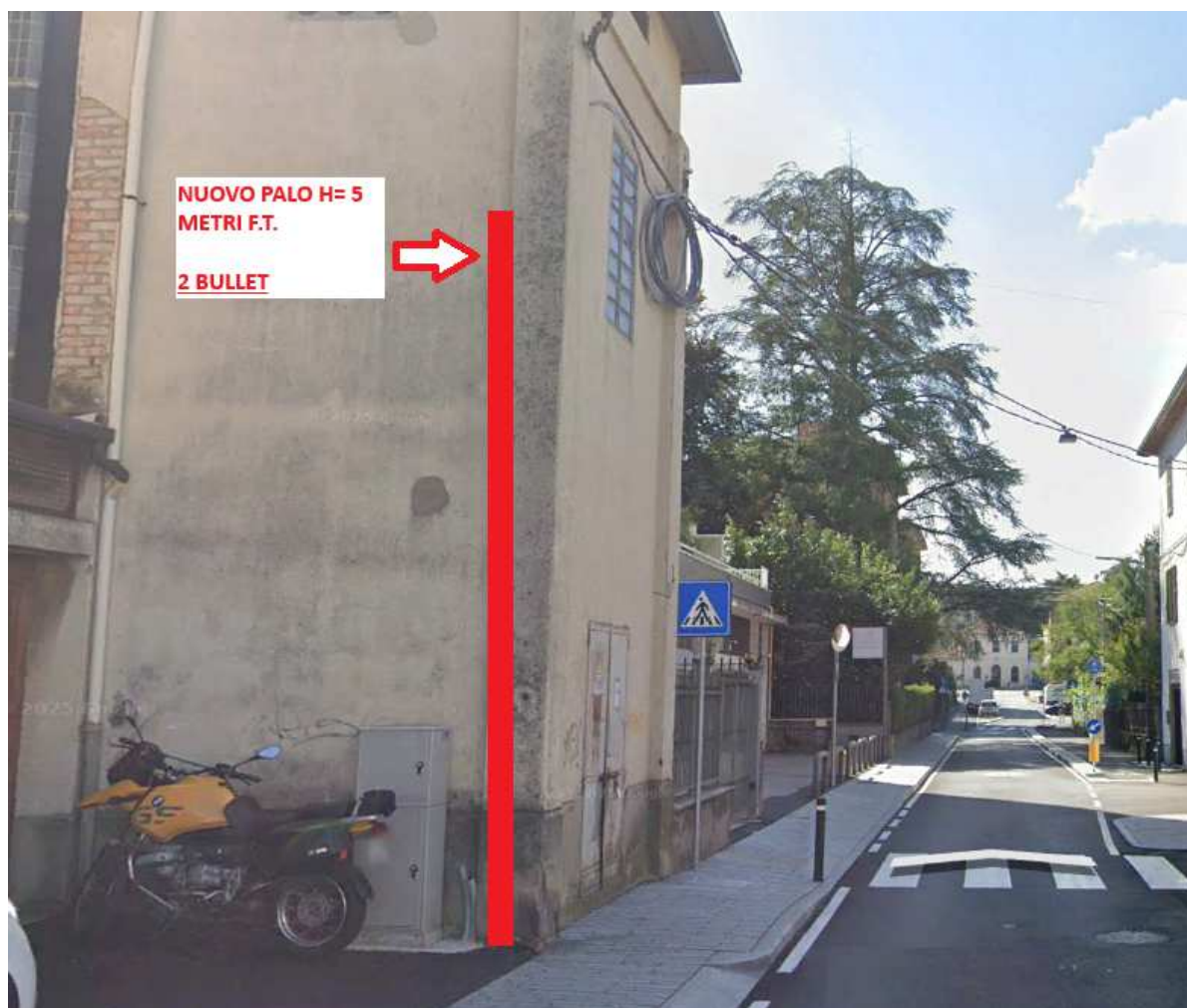
Foto 6 – Palo di installazione delle telecamere
