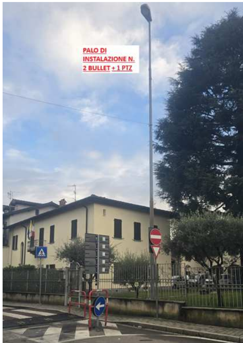
Foto 13 – Palo di installazione delle telecamere
