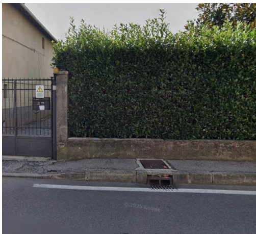
Figura 6 - Bocca di lupo per raccolta acque
