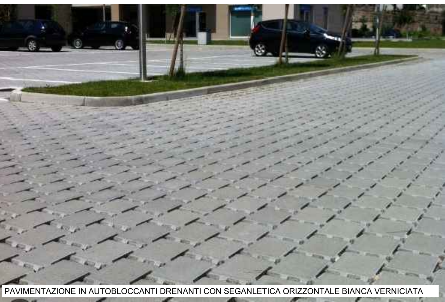
PAVIMENTAZIONE IN AUTOBLOCCANTI DRENANTI CON SEGNETICA ORIZZONTALE BIANCA VERNICIATA
