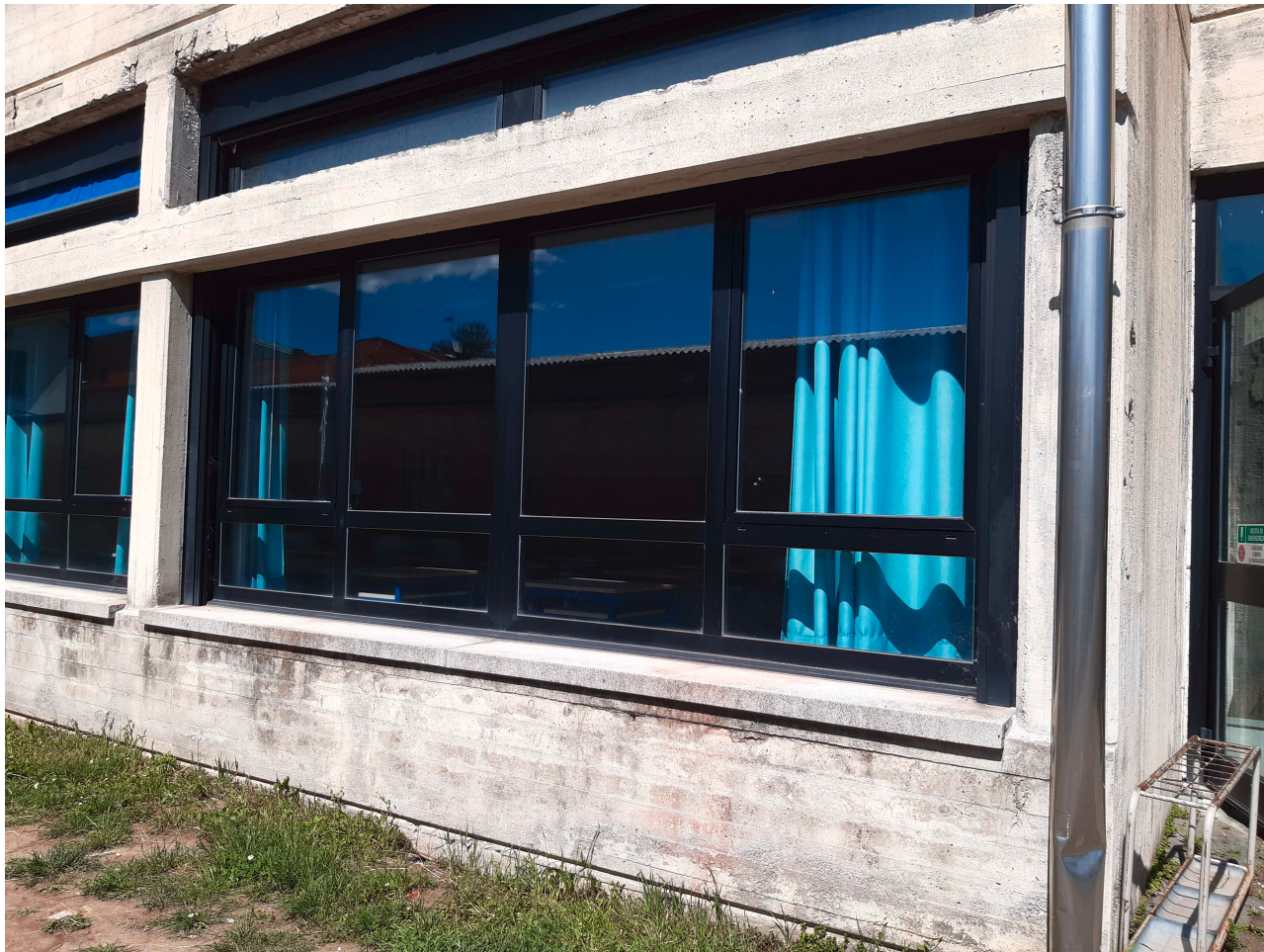
Vista del prospetto ovest – dettaglio esterno
