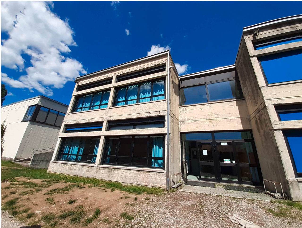
Vista del prospetto ovest
