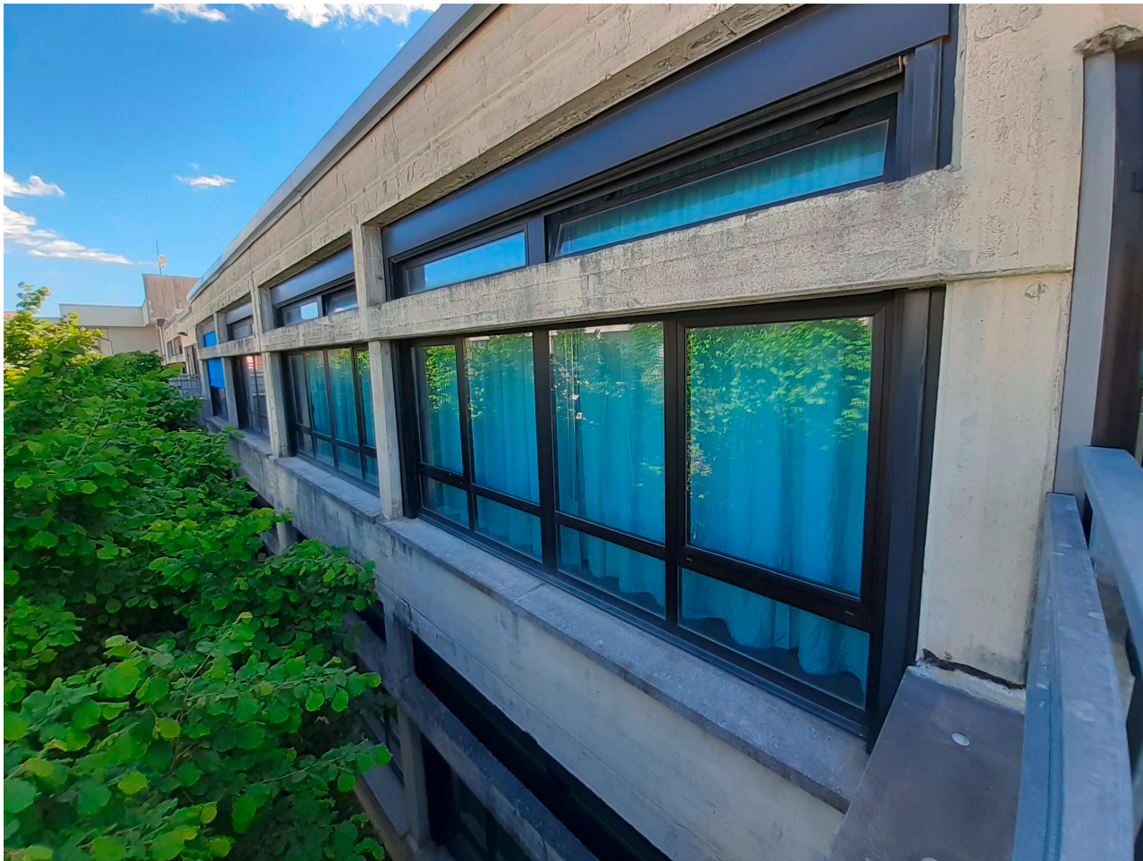
Vista del prospetto est cortile interno
