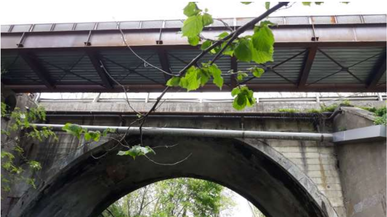
Figura 3. Passerella a sbalzo sul fiume Quadronna vista dall'alveo
