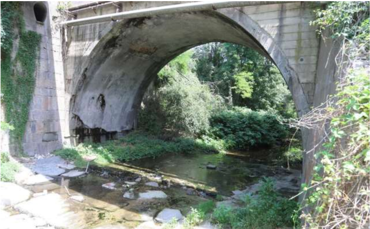
Figura 2. Ponte visto da valle verso monte – Luglio 2019
