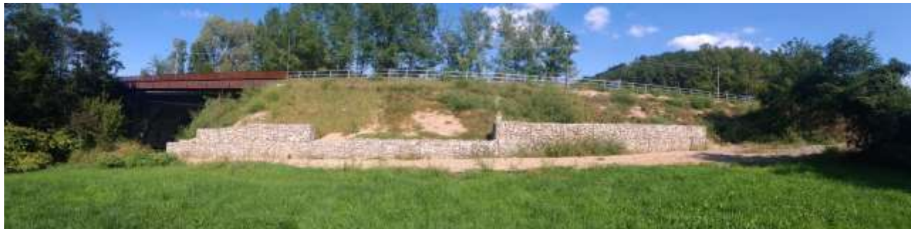
Figura 11. Gabbioni costruiti a sostegno della scarpata della ciclabile in sponda sinistra – Settembre 2019
