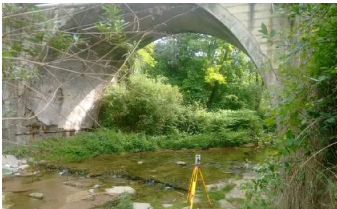
Figura 17. Ponte sul t. Quadronna – Malnate: rilievo con stazione totale
