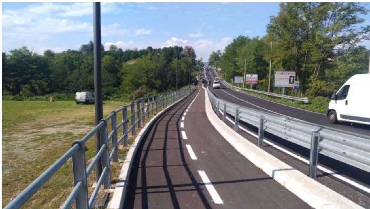
Figura 12. Ciclabile con parapetto e guard rail di protezione – Settembre 2019
