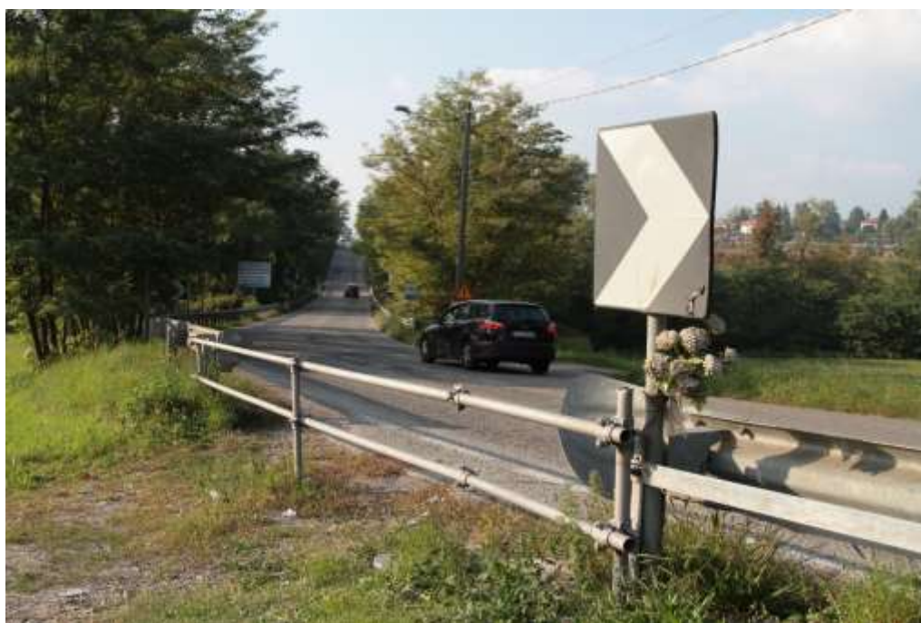
Figura 30. SS342 prima della realizzazione della ciclabile (Ottobre 2017)
