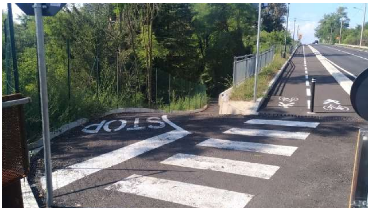
Figura 15. Accesso alla ciclabile delimitato da una recinzione continua verso valle
