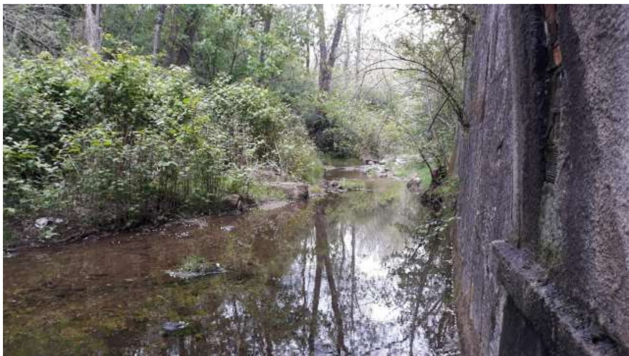
Figura 10. Sponda sinistra monte e depositi vegetati in sponda destra – Maggio 2019
