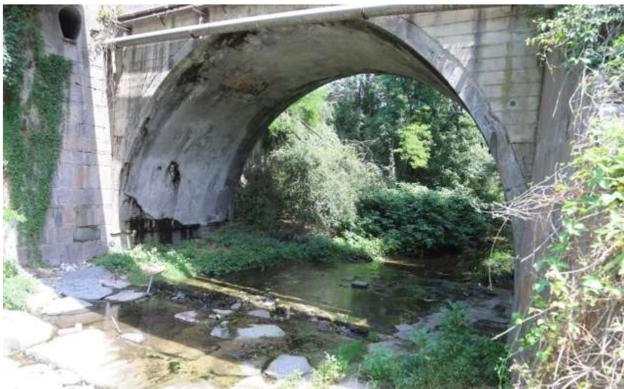
Figura 7. Ponte visto da valle verso monte – Luglio 2019
