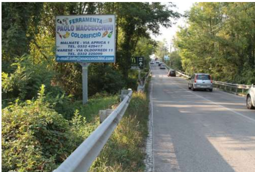
Figura 31. SS342 prima della realizzazione della ciclabile (Ottobre 2017)
