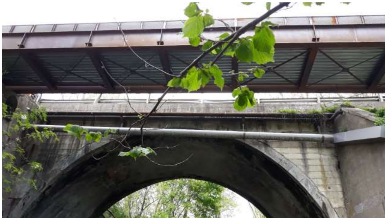
Figura 14. Passerella a sbalzo sul fiume Quadronna vista dall'alveo
