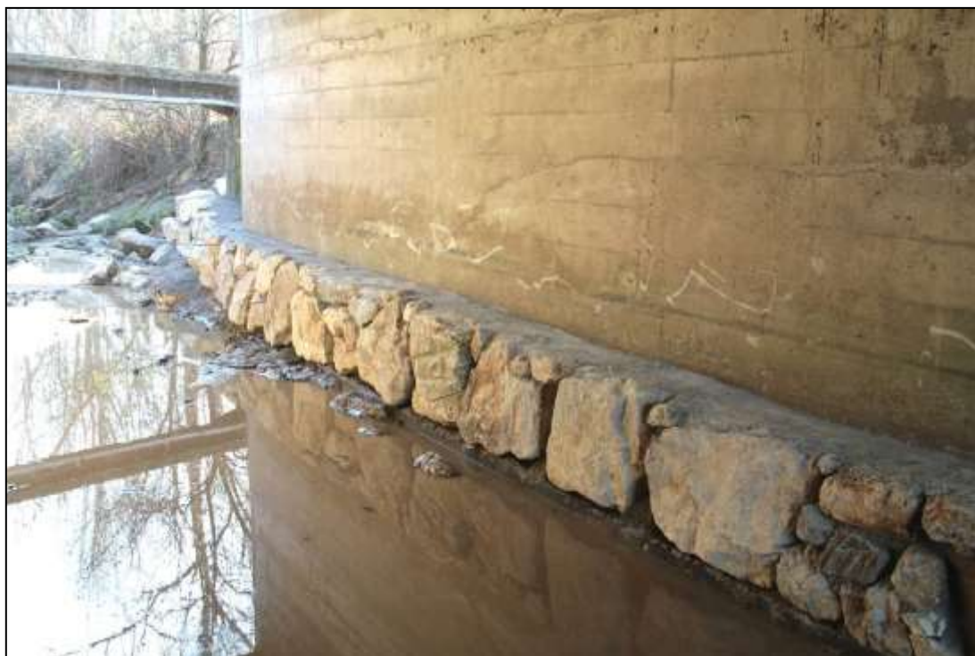
Figura 37. Passerella in massi cementati
