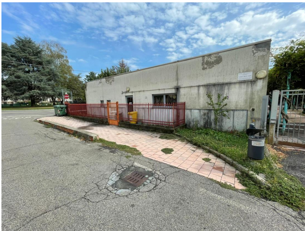
Foto 1 - Area di deposito materiale; WC chimico; baracca di cantiere
