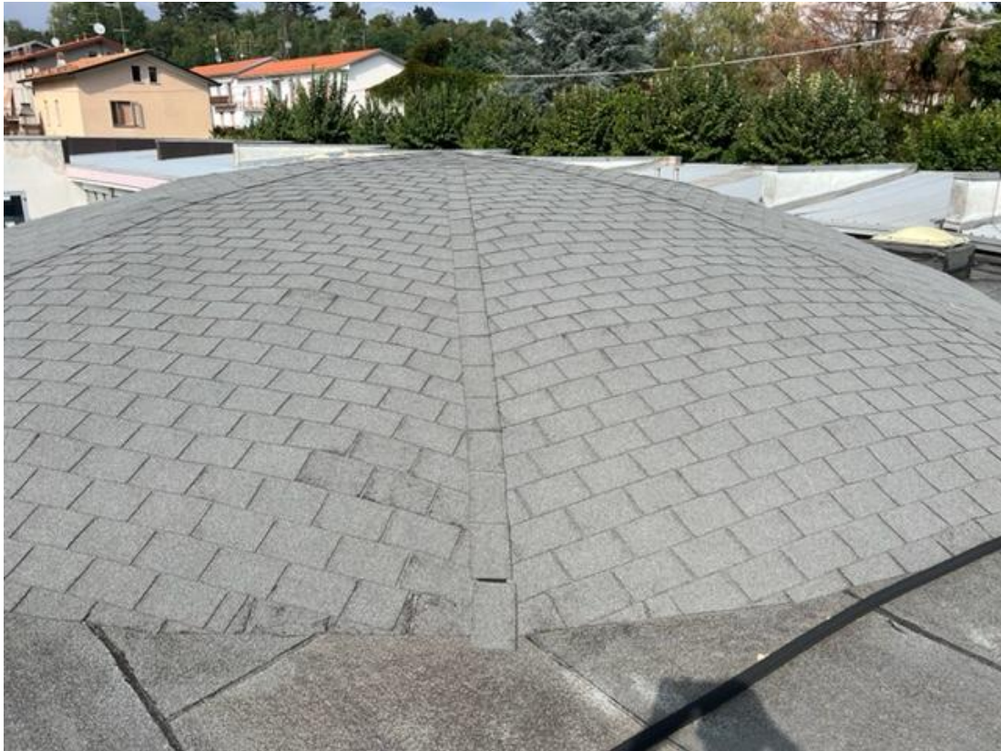
Foto 9 – Particolare costruttivo cupola in tegole canadesi porzione 1
