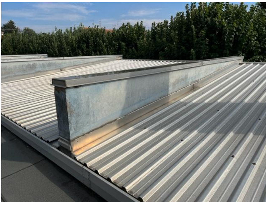
Foto 8 – Particolare costruttivo divisorio porzione 2 della copertura
