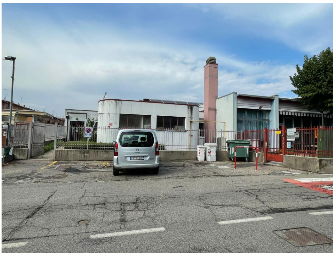
Foto 3 - Area di accesso pedonale al cantiere
