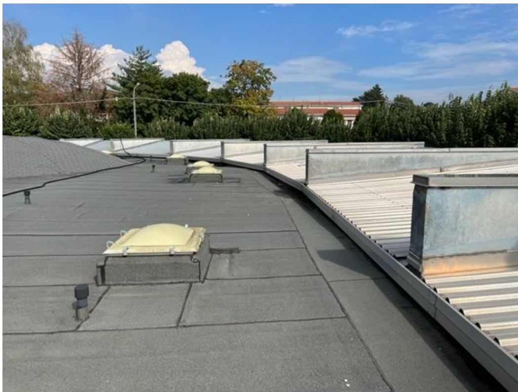
Foto 7 – Vista copertura porzione 1 e 2
