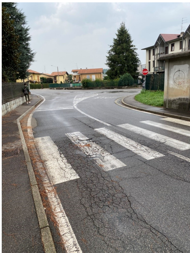
Foto 5: Via Don Maisani - rampe per attraversamento pedonale a raso
