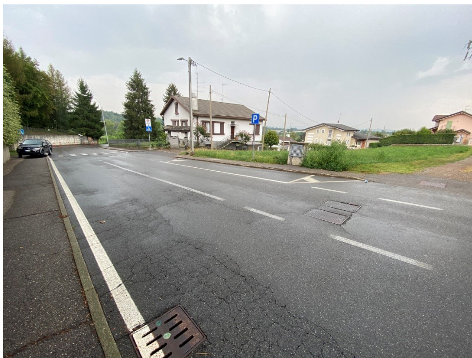
Foto 15: Via Settembrini luogo installazione attraversamento rialzato
