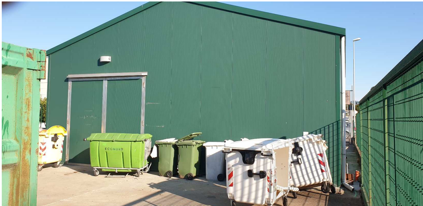
Foto 01 - Vista del prospetto sud del Centro del Riuso
