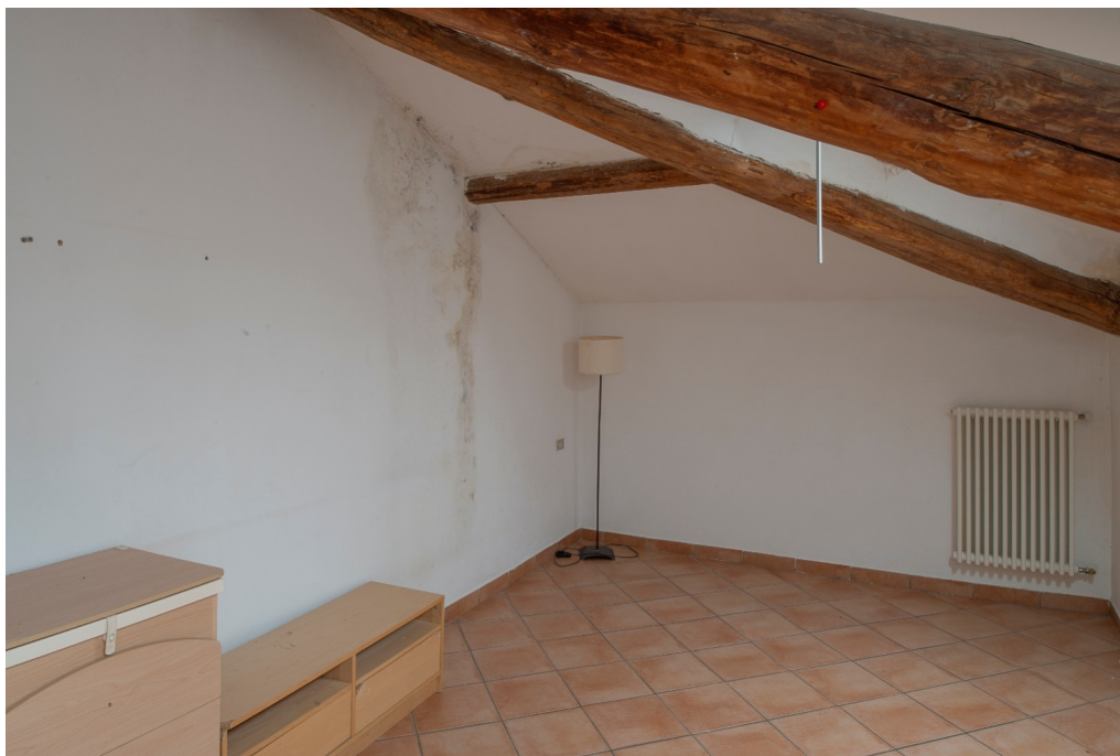
Viste Appartamento ricavato in parte del sottotetto
