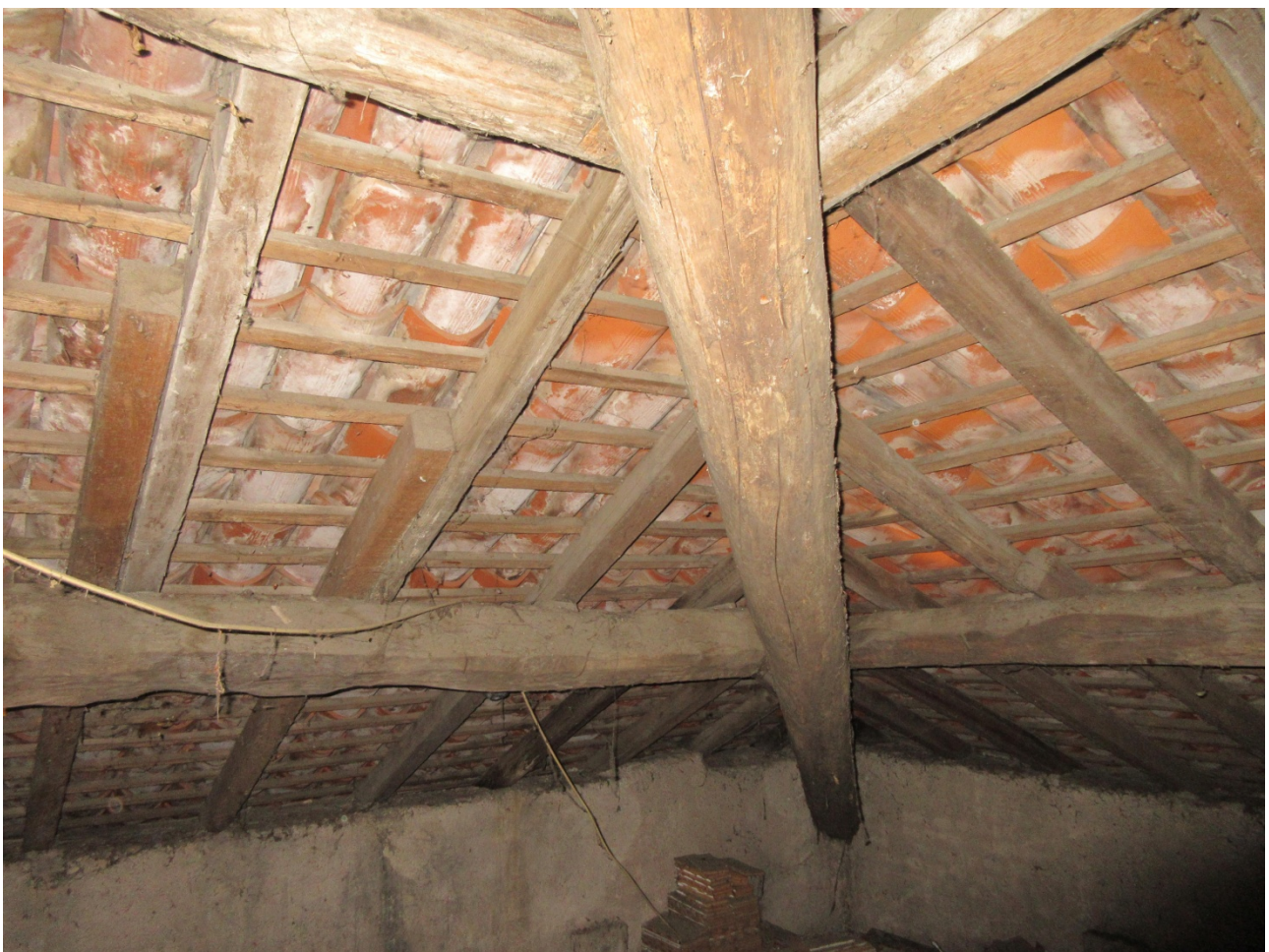
Manto di copertura visto dal sottotetto
