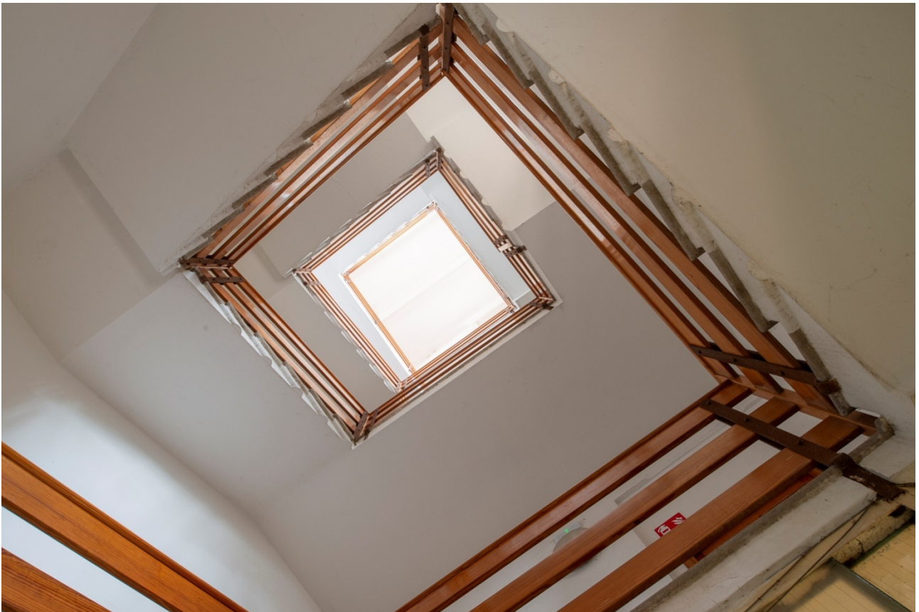
Vano scale costituito da rampe a sbalzo in ca con pedate in serizzo
