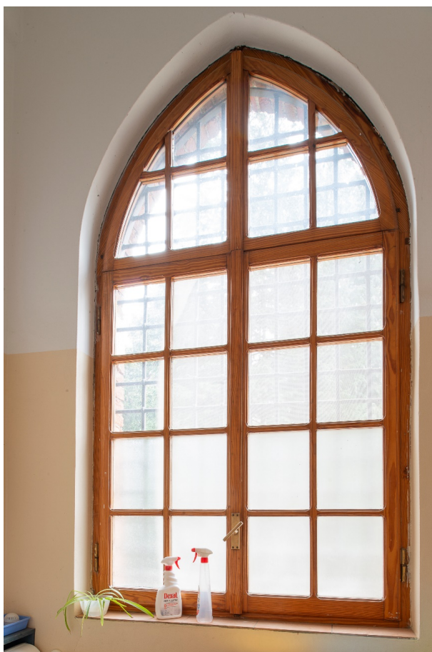
Vista serramenti lignei – 1974 – doppio battente con sopraluce fisso ad arco acuto
