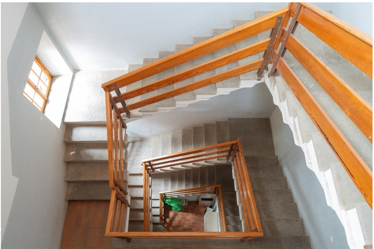
Vano scale costituito da rampe a sbalzo in ca con pedate in serizzo
