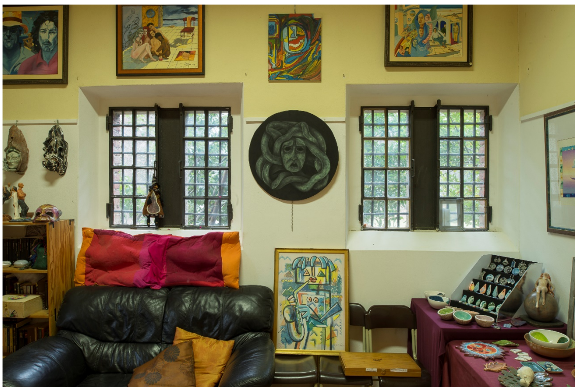
Viste serramenti in ferro a due ante con montante pieno fisso centrale
