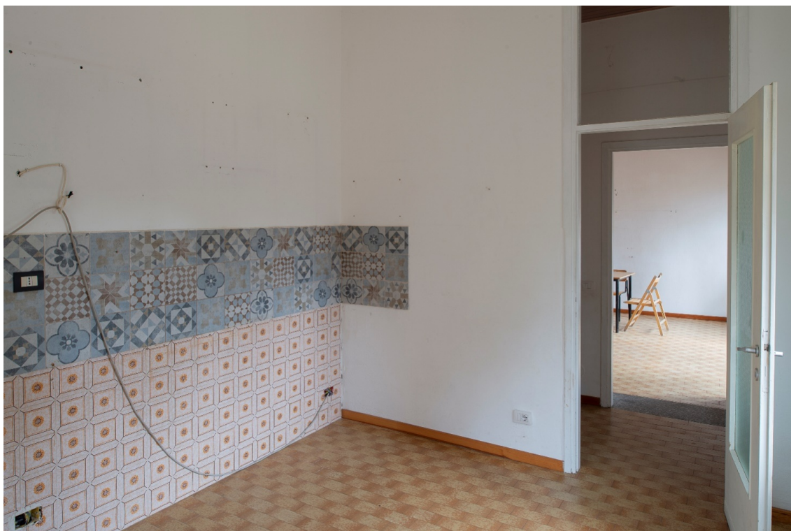
Viste interne – Bucatura circolare tamponata con serramento ligneo a due battenti
