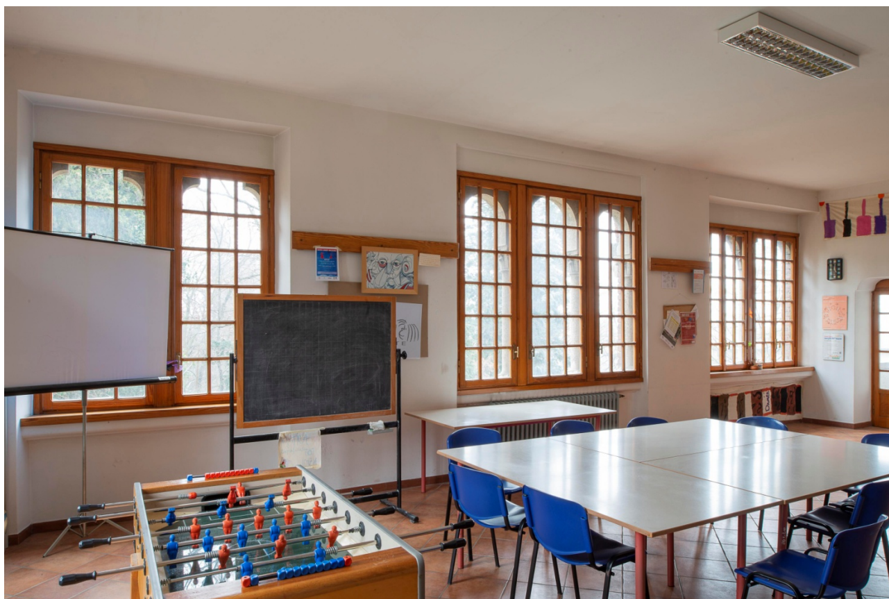
Vista dei serramenti dall'interno - esempio
