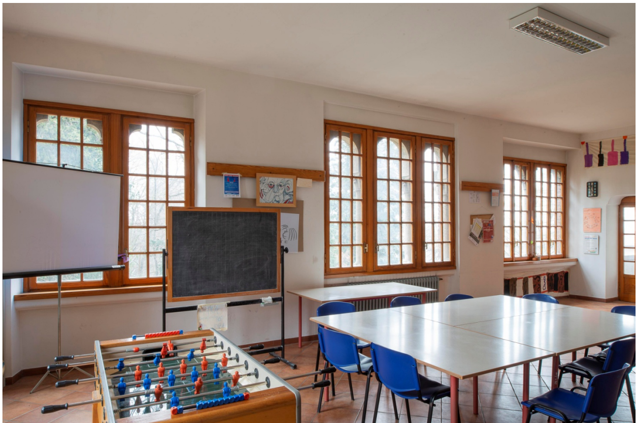
Vista dei serramenti dall'interno - esempio
