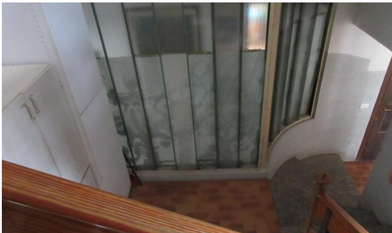
Perimetro del vano scala in U-glass
