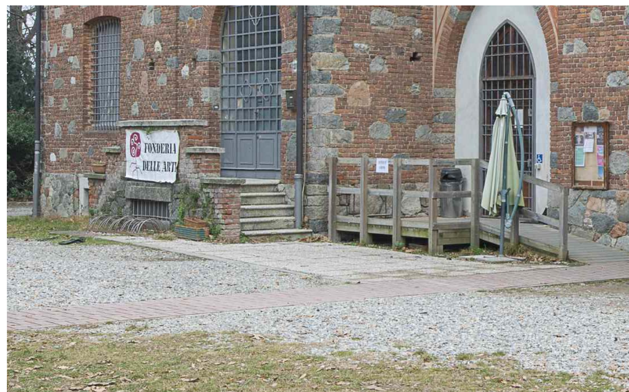
Pavimentazione esterna Rampa 1 Stato di fatto
