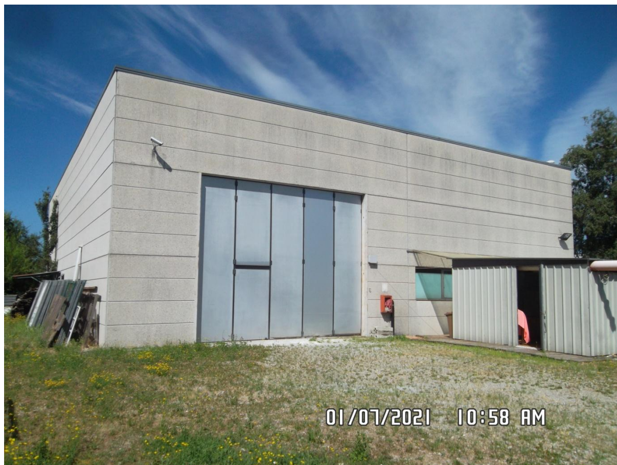
Vista del fabbricato con la struttura tipo container
