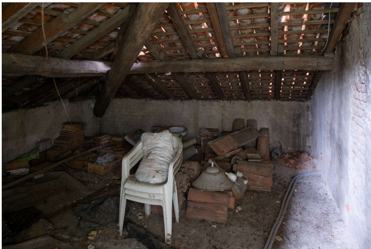
Viste Strutture lignee a vista costituite da puntone angolare, terzere, travetti e listelli. La banchina è in muratura.
