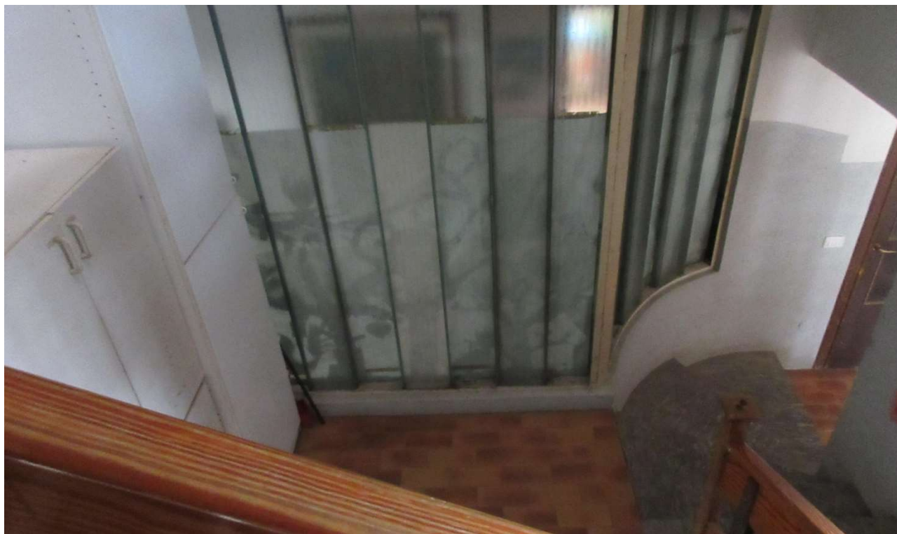
Perimetro del vano scala in U-glass
