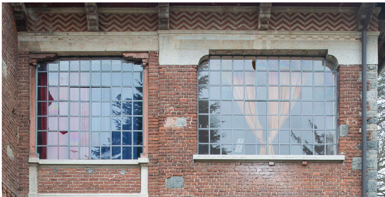
Vista dei serramenti in ferro dall'esterno – esempio
