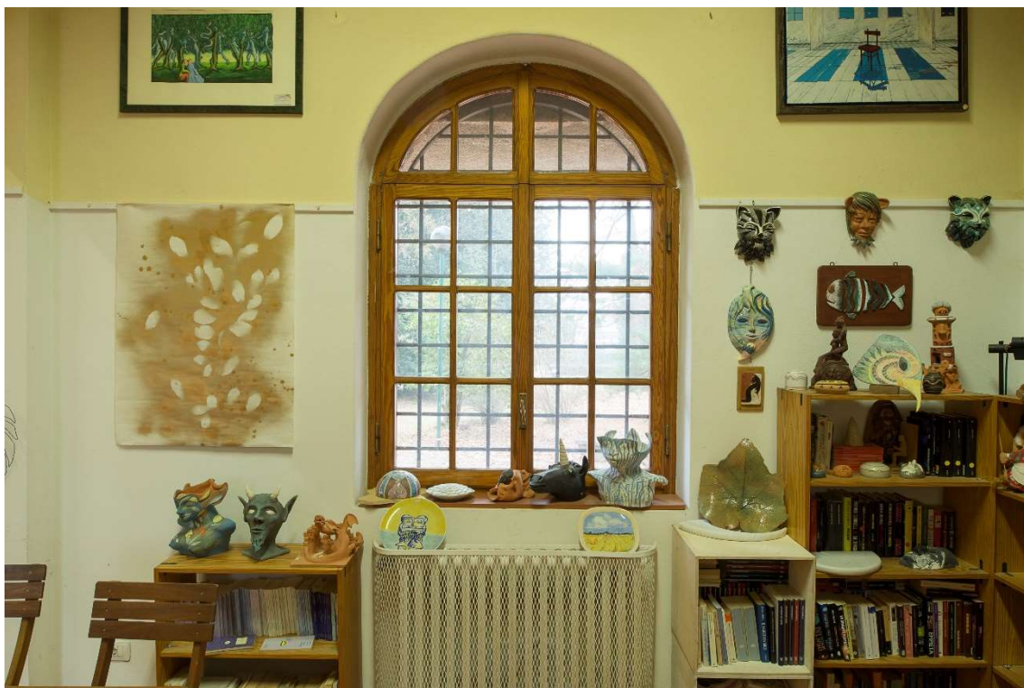
Vistaserramenti lignei – 1974 – doppio battente con sopraluce fisso ad arco a tutto sesto
