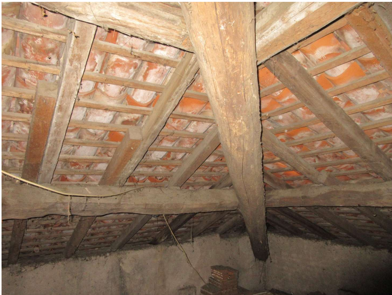
Manto di copertura visto dal sottotetto - esempio
