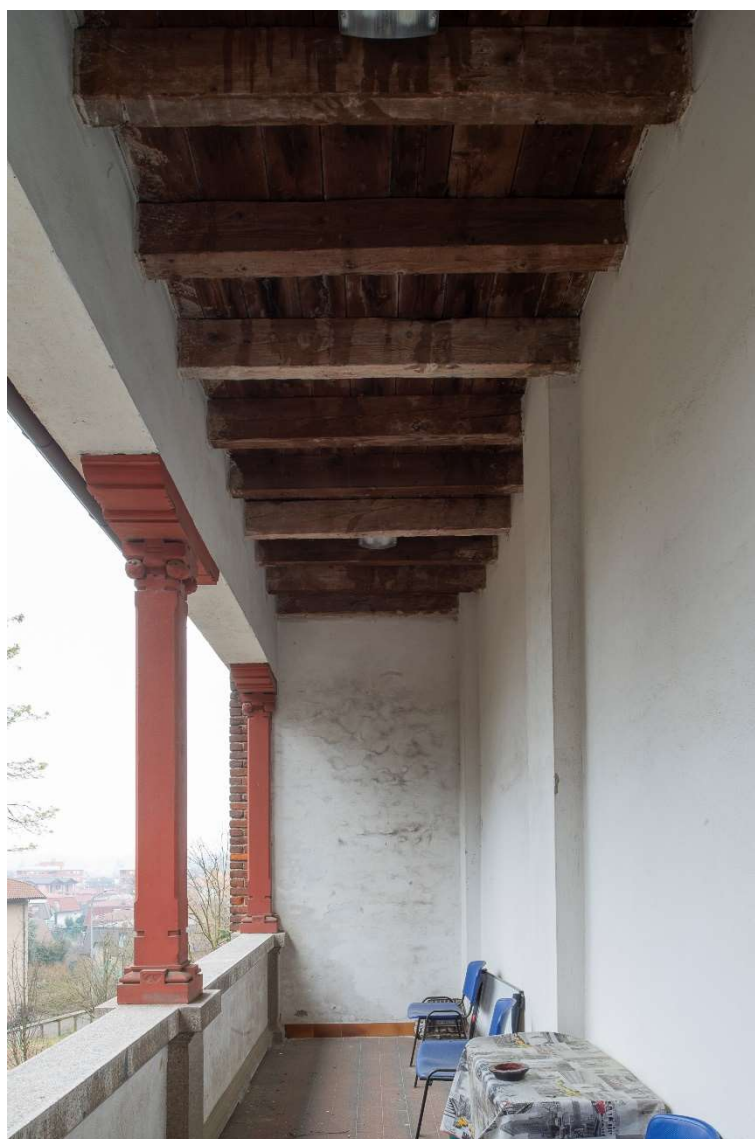
Loggia la piano primo l'unico soffitto ligneo a vista
