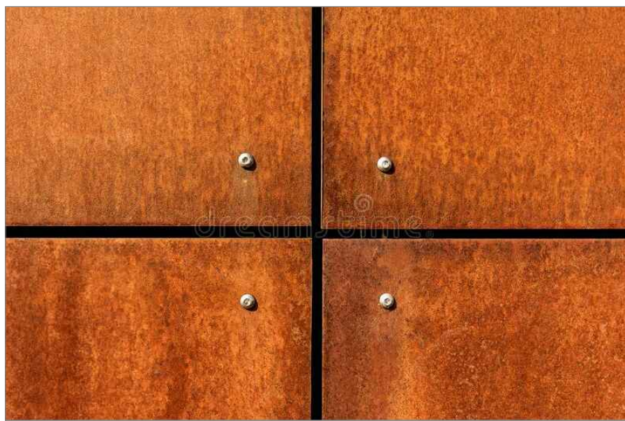
Esempio fissaggio lastre CORTEN
