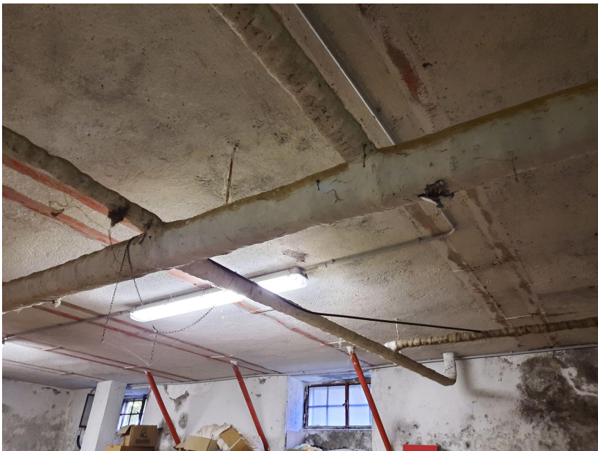
Immagine #11 - Comune di Malnate - Villa Ponzoni - Il sistema di distribuzione al piano interrato.
