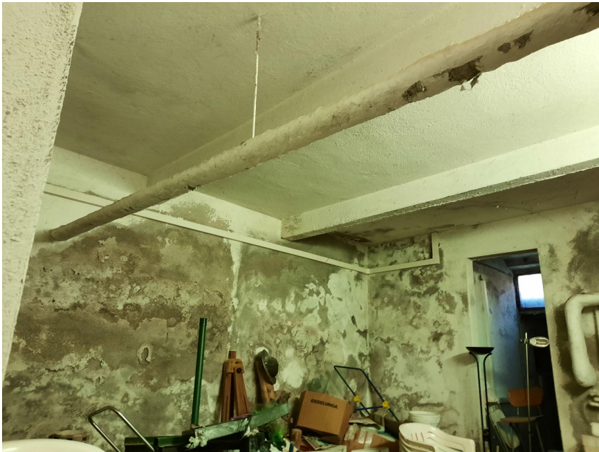
Immagine #10 - Comune di Malnate - Villa Ponzoni - Il sistema di distribuzione al piano interrato.
