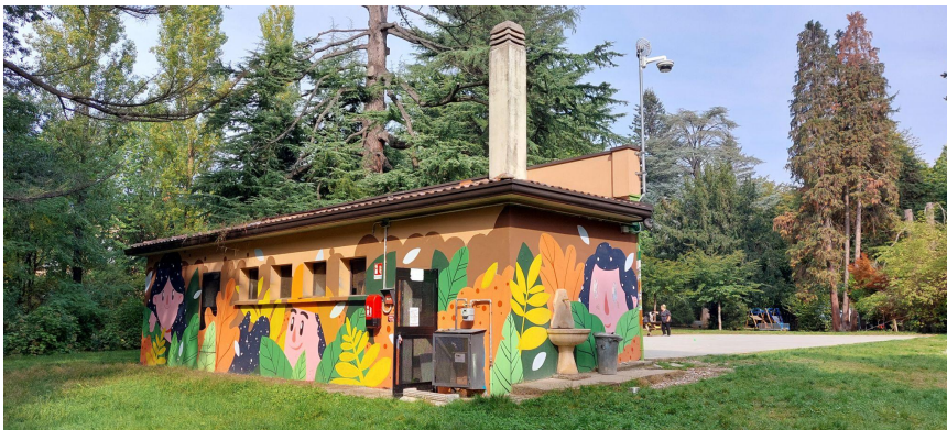
Immagine #24 - Comune di Malnate - Villa Ponzoni - Il volume tecnico all'esterno dell'edificio contenente il locale centrale termica, il locale magazzino e i bagni pubblici.
