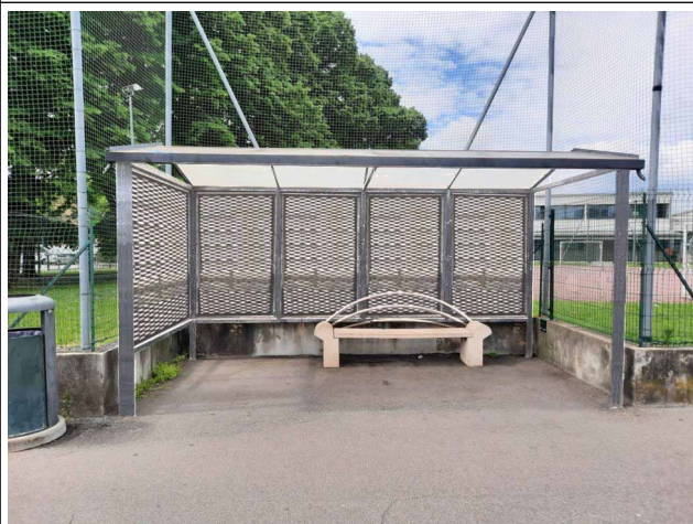
INSERIMENTO PANNELLI IN LAMIERA, VERNICIATURA DELLA STRUTTURA, RIMOZIONE DEL PALO CENTRALE E SOSTITUZIONE/RAFFORZAMENTO DEI LATERALI
