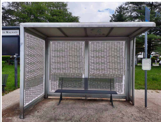
INSERIMENTO PANNELLI IN LAMIERA VERNICIATURA DELLA STRUTTURA
