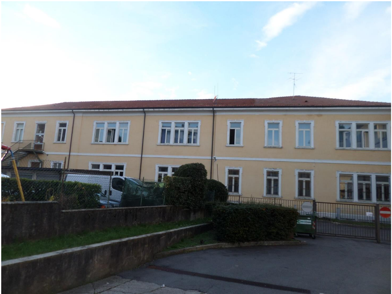
Foto 4 : Vista generale prospetto EST
