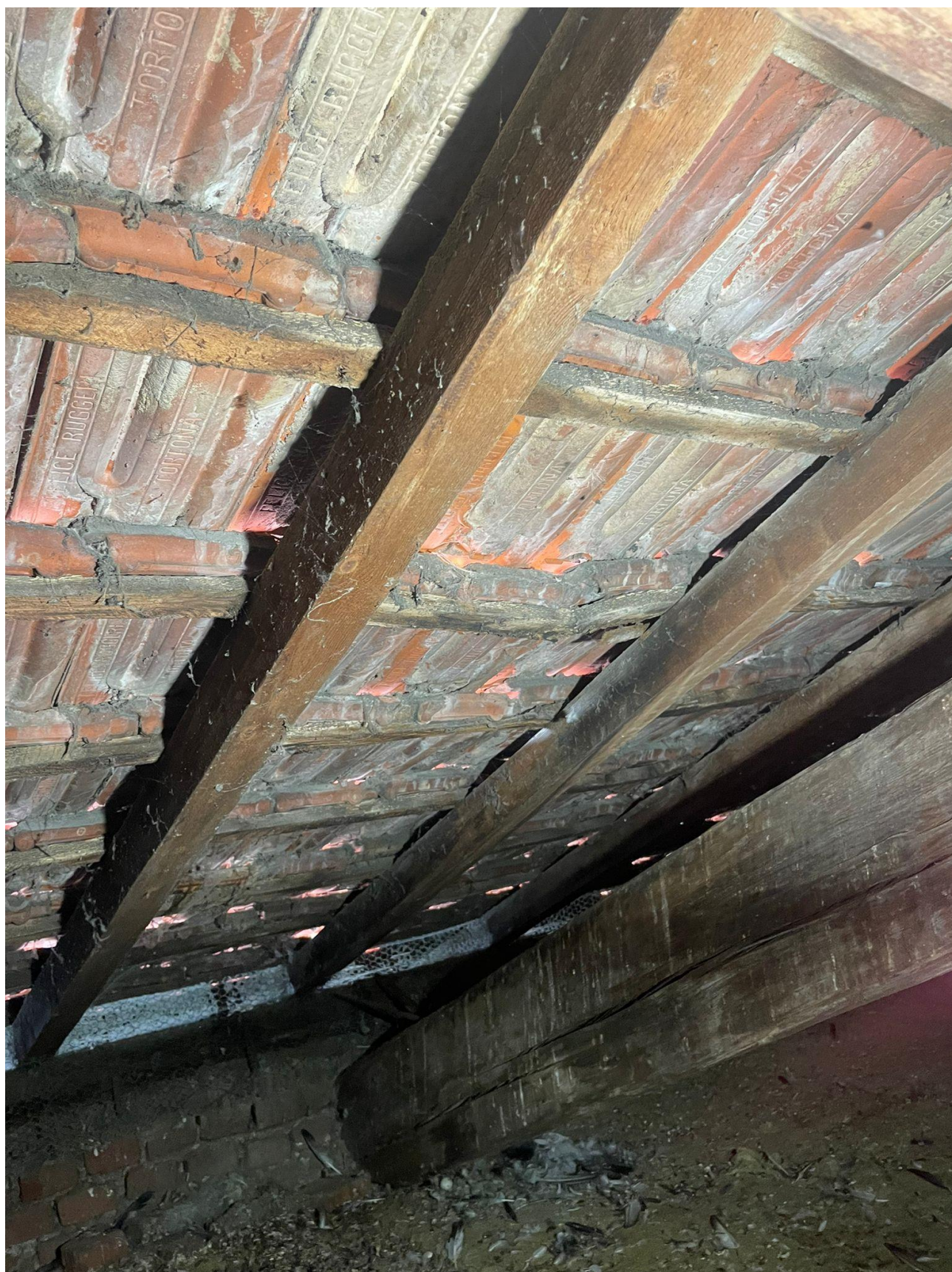
Foto 7 : Particolare della copertura da sostituire
