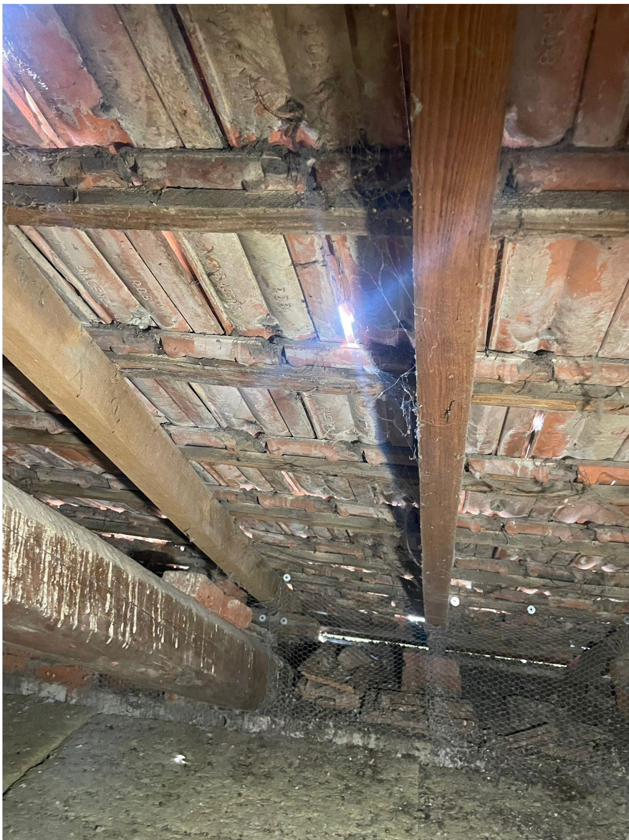
Foto 6 : Particolare della copertura da sostituire
