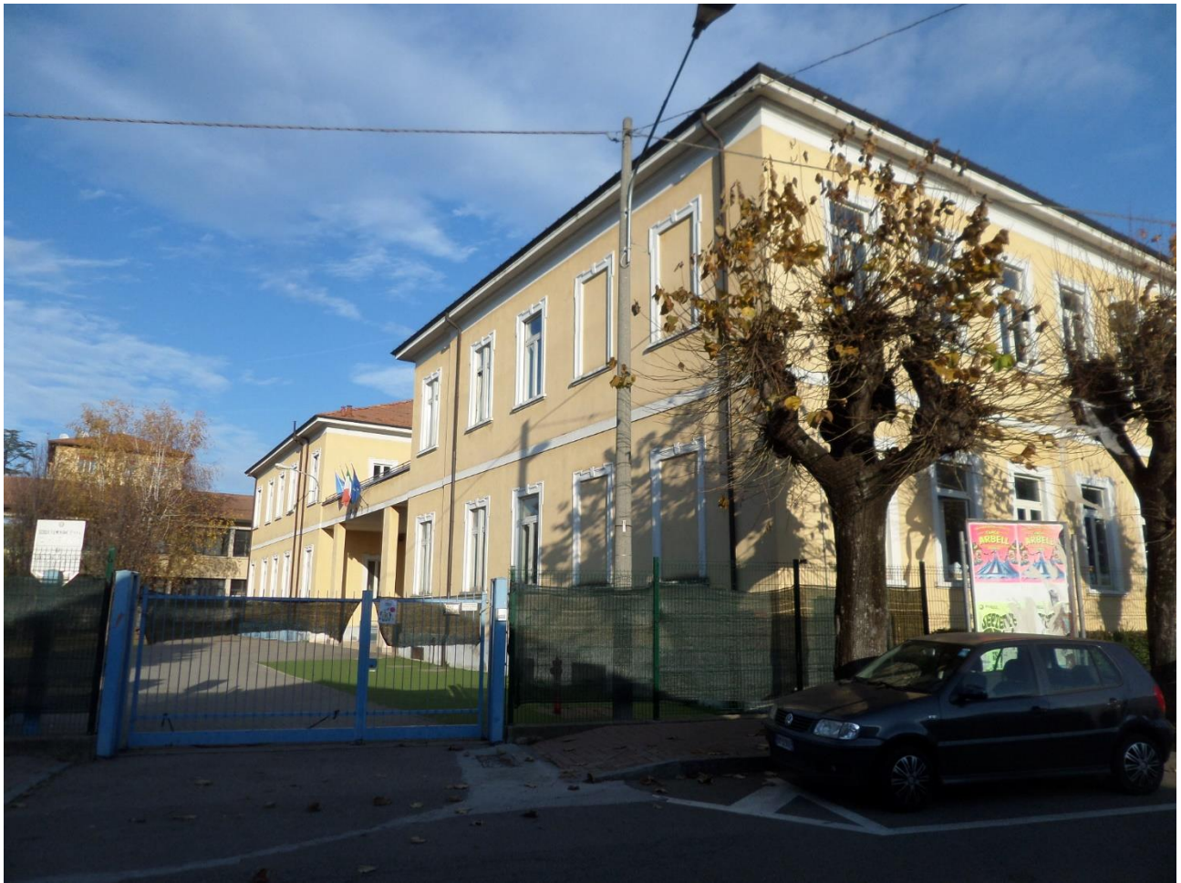
Foto 2 : Vista prospetto OVEST e SUD da Via De Mohr
