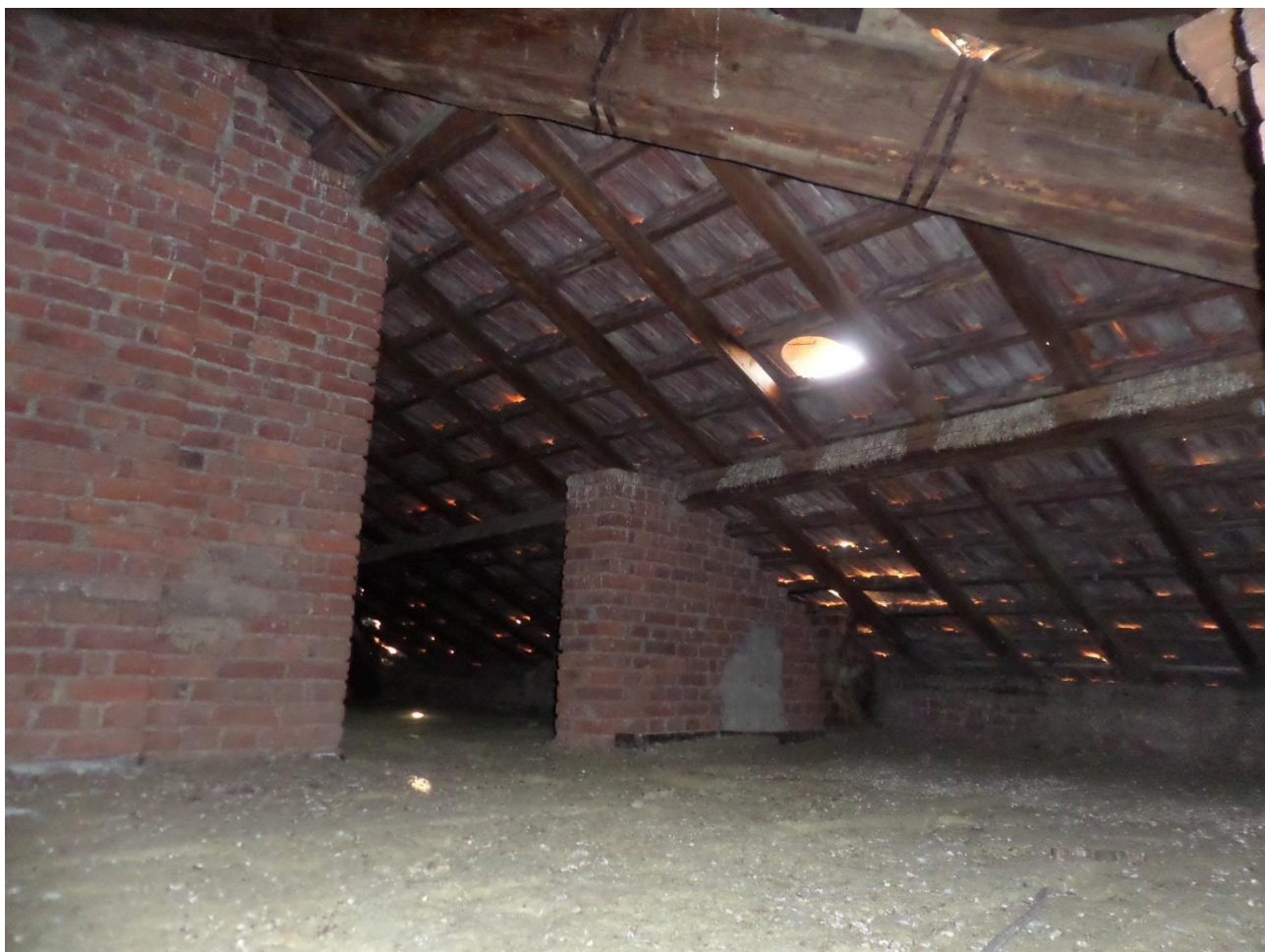
Foto 5 : Vista interna copertura da sostituire
