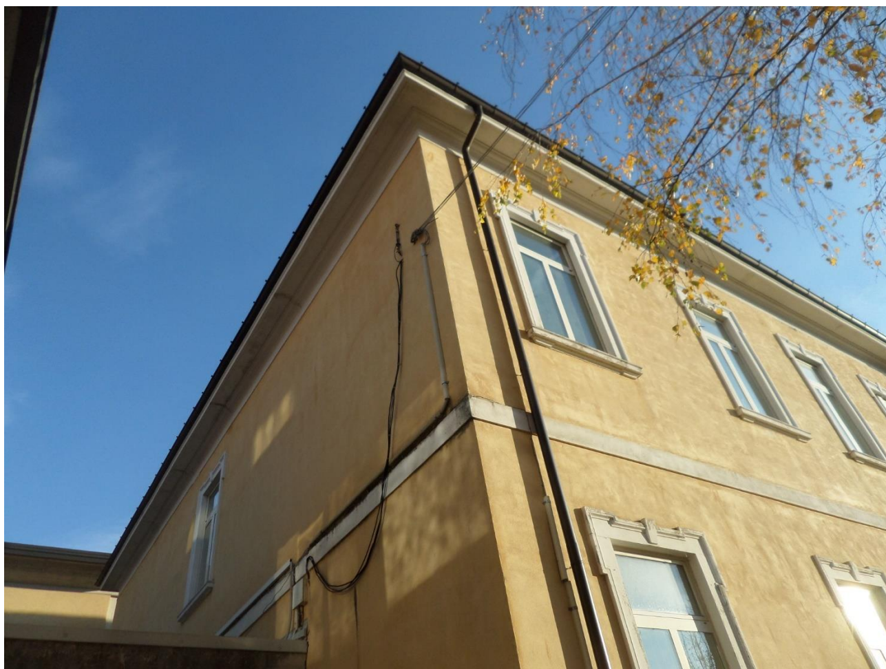
Foto 3 : Vista prospetto Nord
