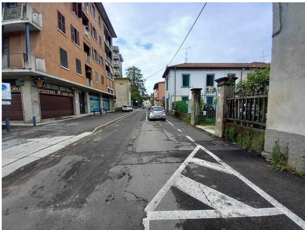
Via Matteotti, tratto intermedio (vista da nord a sud)
