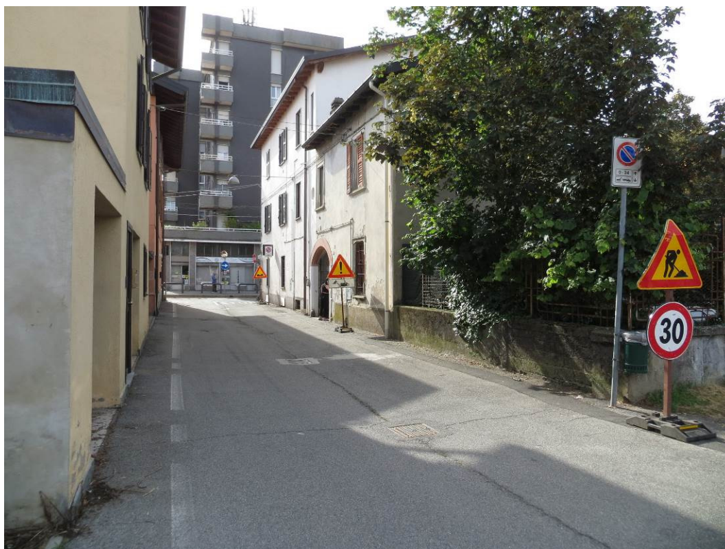
Via Verdi, tratto da incrocio via San Giuseppe a incrocio via Matteotti (vista da est a ovest)
