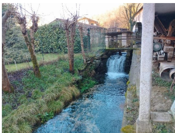
Tombinatura in arrivo alla frazione della Roggia Molinara e canali di presa per il Mulino Bernasconi
