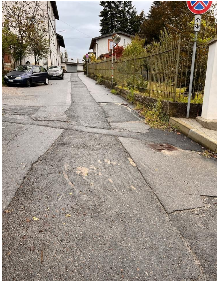
Nuova fognatura nera realizzata dal gestore del servizio idrico
