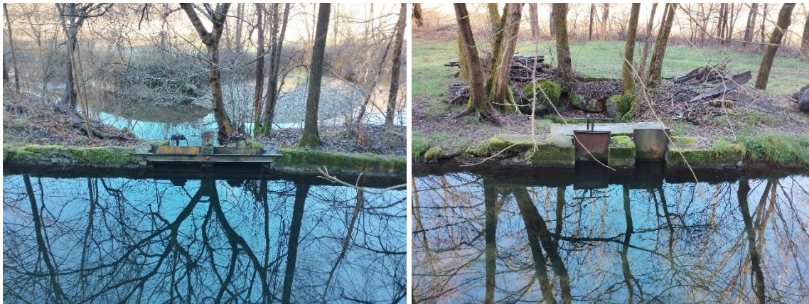
Paratoie di regolazione in ordine a monte ed a valle
