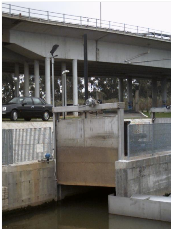
Esempio paratoia motorizzata (Fonte O.M.IT. srl)
