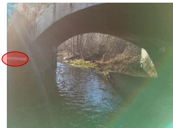
Scarichi in prossimità della Frazione Folla. Probabili scarichi delle utenze dalla corte di Via Zara n.5
