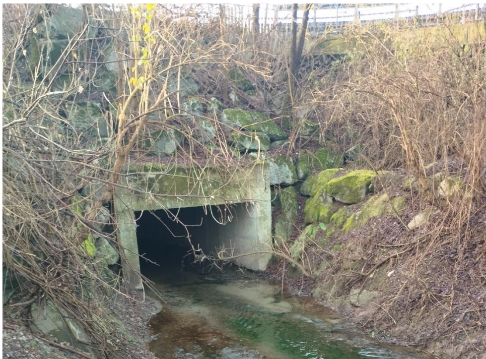
Tombinatura sul passaggio sotto la strada statale della Roggia Molinara
