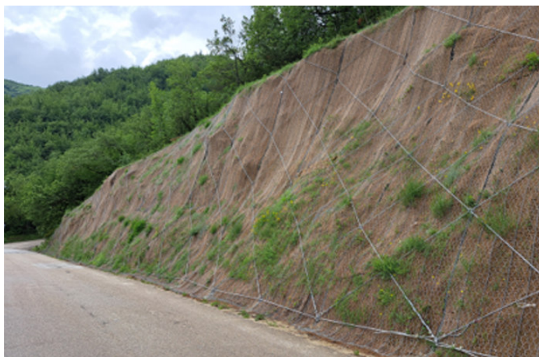
FIG. 18 – SCARPATA STRADALE CON RAFFORZAMENTO CORTICALE
