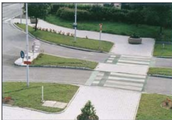
Figura 82: esempio layout pista bidirezionale in rotatoria
