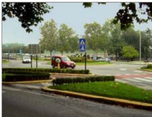
Figura 81: attraversamento ciclopedonale in rotatoria
