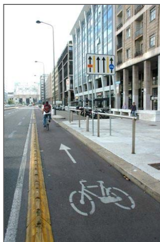
Figura 75: Esempio di pista monodirezionale riservata: separazione tramite segnaletica e cordolo.
