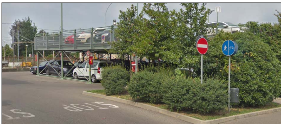
Figura 94: Esempio di un parcheggio soppalcato in stazione
