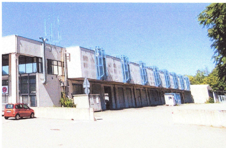
Facciata nord-est – Vista d'insieme
