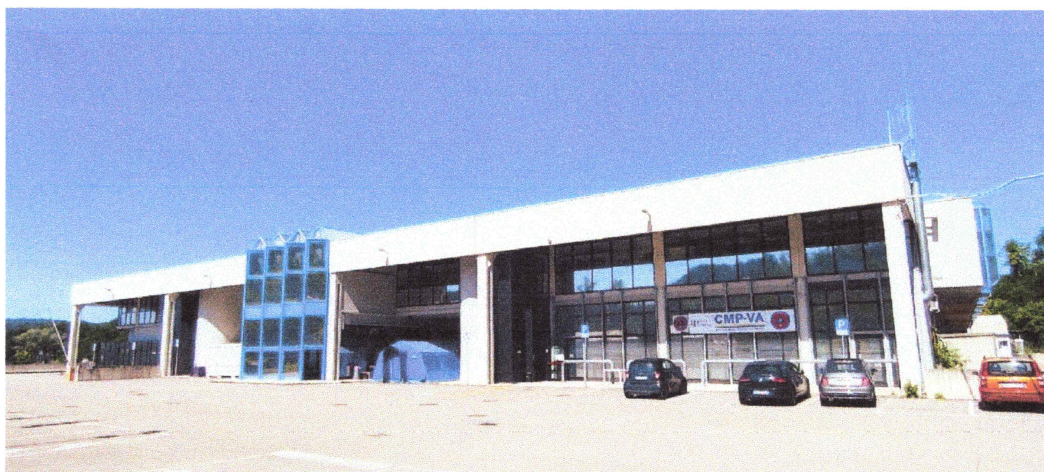
Facciata sud-est – Vista complessiva
